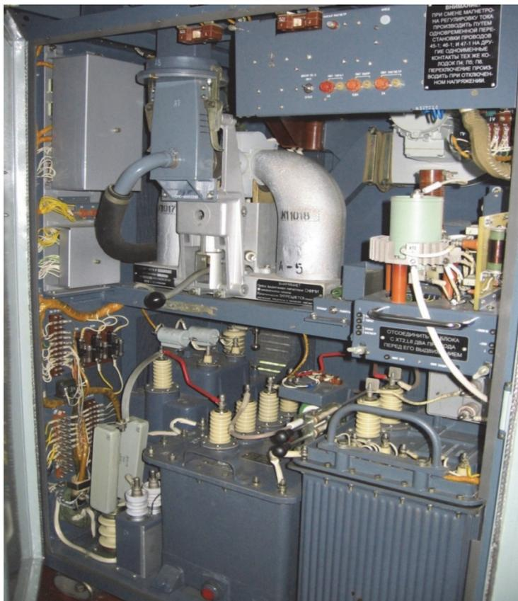
Рис. 2.9. Шкаф передатчика ПС с открытыми дверцами и снятым с контакторов кожухом
