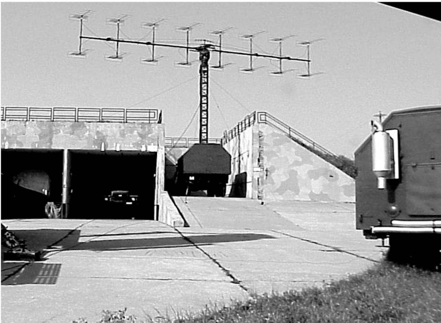
Рис. 1.7. Вариант размещения РЛС П-18Р в защищенном инженерном сооружении
