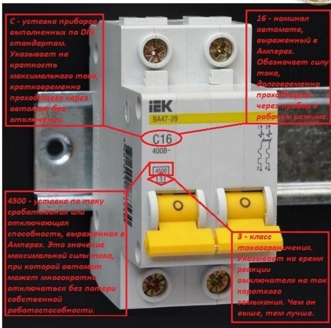
**C** - установка приборов, выполненных по DIN стандарт. Указывает на кратность максимального тока, кратковременно проходящего через автомат без отключения.
