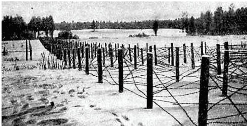
Рис. 3. Проволочное заграждение перед передним краем
